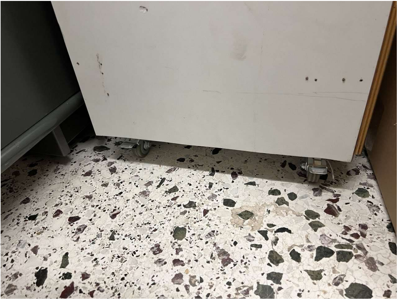
Εικόνα 4γ: Τελική κατασκευή
